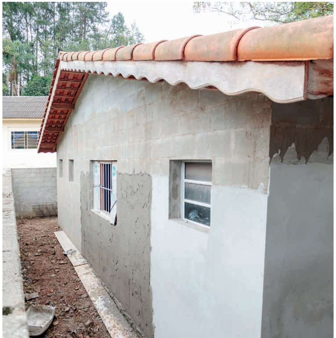
Obra da futura Unidade Básica de Saúde do Parque Petrópolis deve ficar pronta no próximo mês
