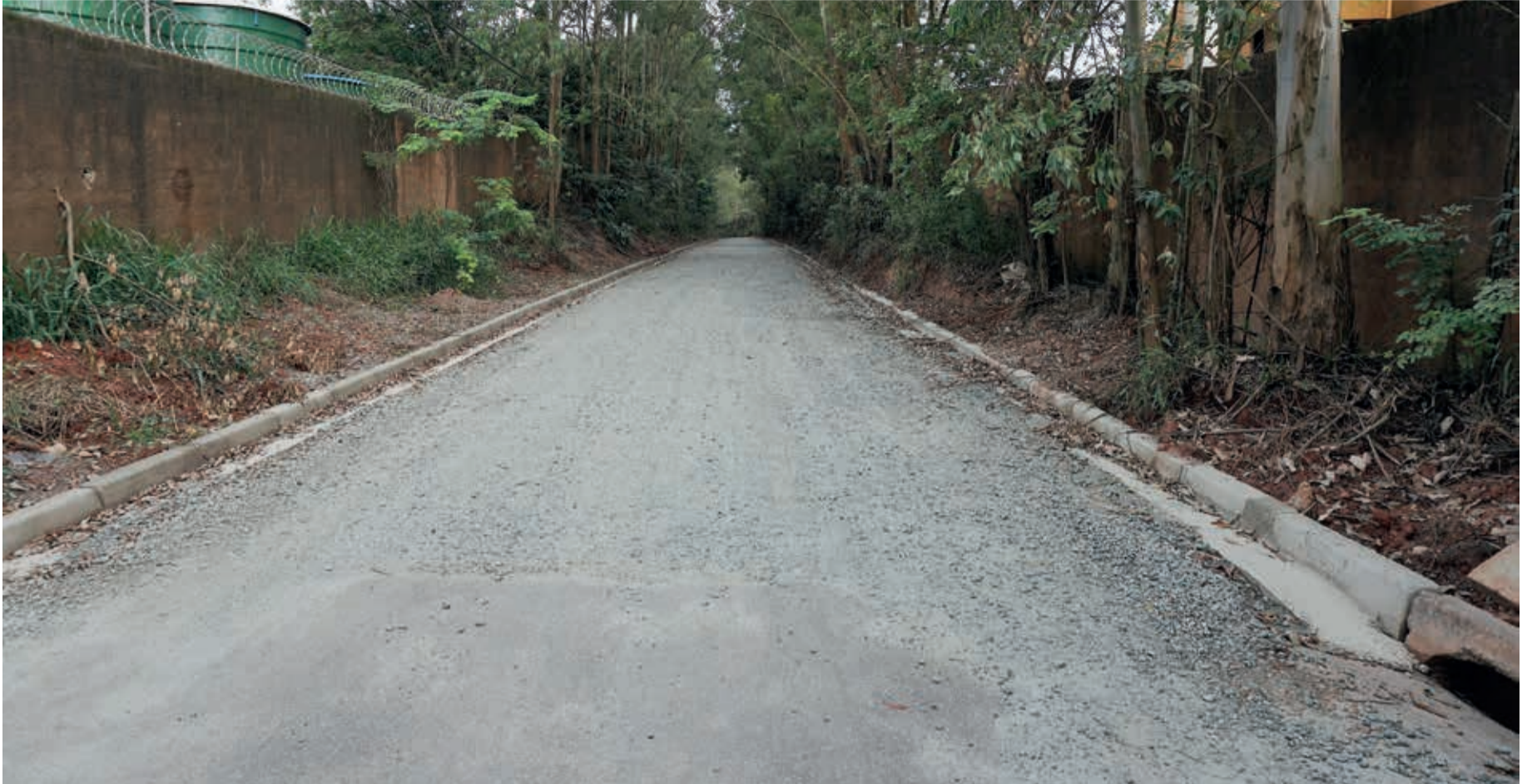
Guias, sarjetas e a base já foram concluídas. A próxima etapa será a aplicação da massa asfáltica
