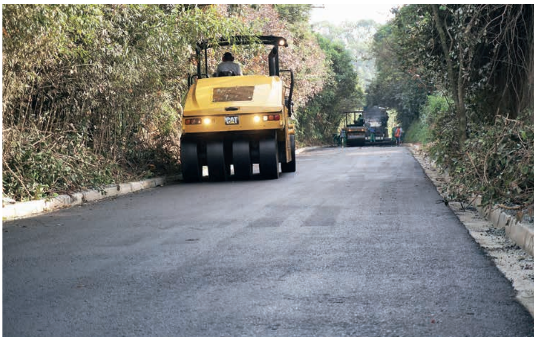
Foram 974,32 metros de asfalto na rua Maria Nunes, Bairro São Vicente
