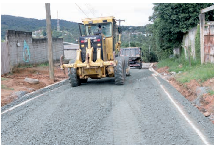
Avenida Berna já está recebendo a base
