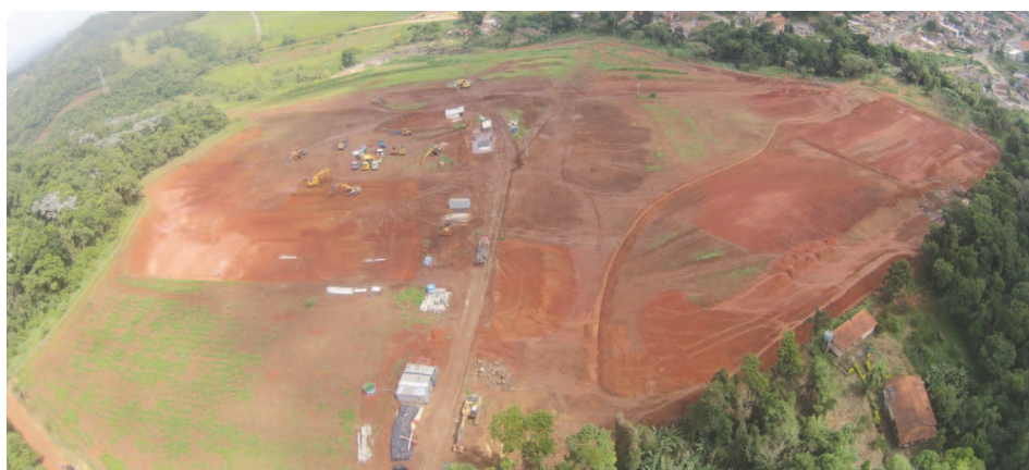
Canteiro de obras instalado em área situada no final da Estrada da Canjica com a Avenida Vitor Odorico, em Terra Preta
